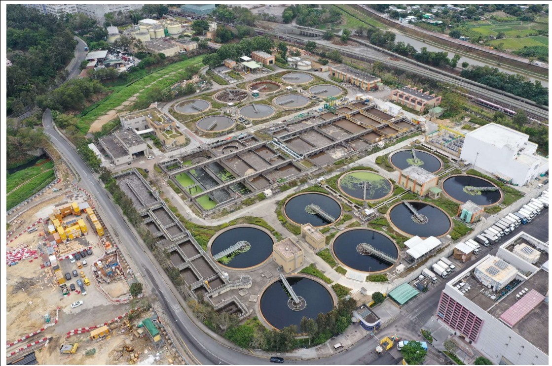
描述: 工地甲及乙部分的1號航拍照片(拍攝於2020年1月17日)
