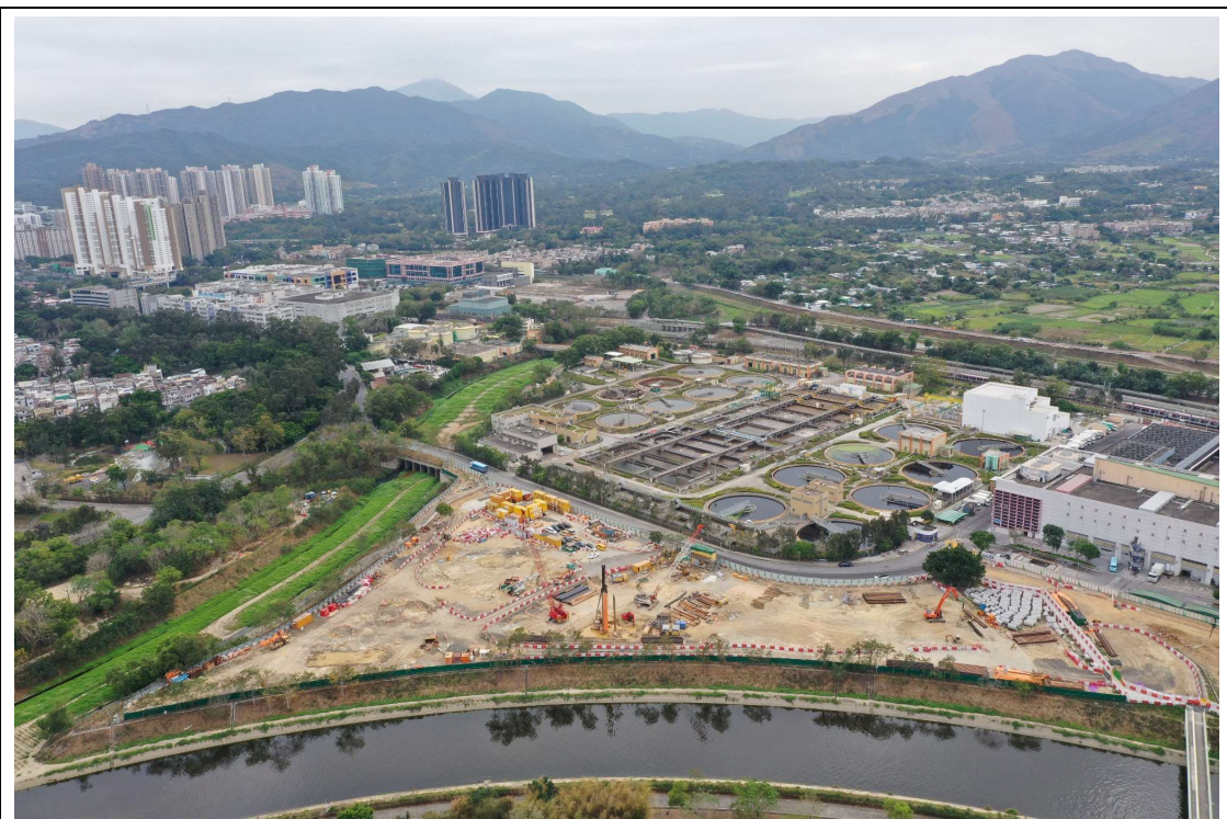
描述: 工地乙及丙部分的2號航拍照片(拍攝於2020年1月17日)
