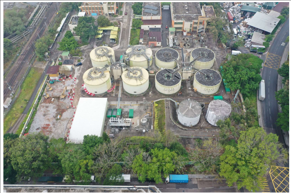
描述: 工地甲部分的1號航拍照片(拍攝於2019年12月31日)
